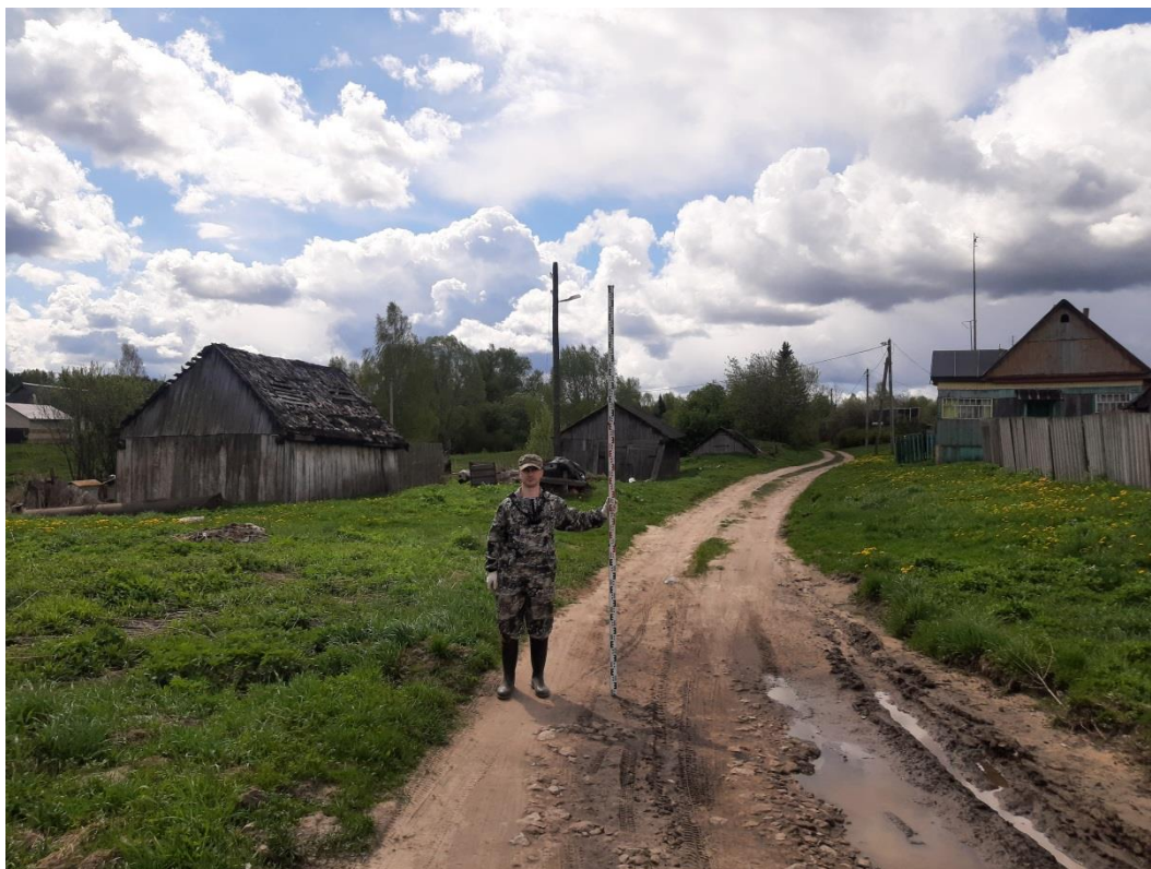
Рис. 18. Участок археологического обследования под объект: «Уличные газопроводы дер. Гранный Холм Козельского района». Видовая точка 9. Вид с юго-запада.
